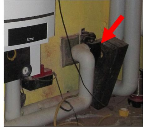
Abgefallene, lose Dämmschale,
