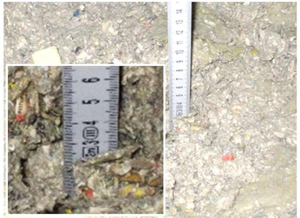
Auf 3 cm(!) reduzierte Dämmstoffstärke,
