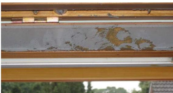
Defekte Dichtungstreifen am Velux-Fenster,
