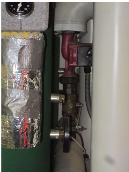
Fehlstellen in der Dämmung,
