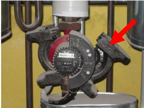
Abgefallene, lose Dämmschale,
