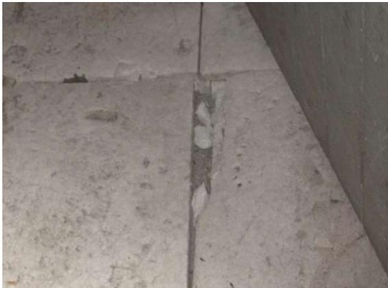
Mangelhafte Dämmung (5 cm Polystyrol),
