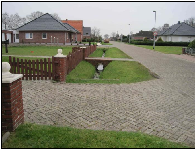
Abbildung 3: Teilaspekt des an der Kapellenstraße verlaufenden Entwässerungsgrabens (Aufnahme vom 06.01.2015, Foto: Verfasser).
