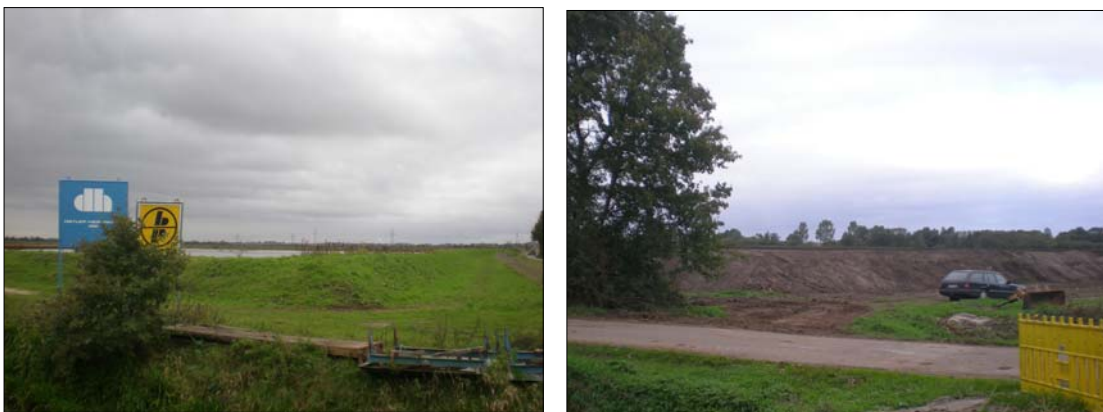
Abbildung 6: Begrünter sowie frisch aufgesetzter, unbegrünter Spüldeich im 3. bzw. 4. Bauabschnitt (Stand: Oktober 2010)
