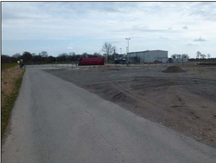
Abbildung 3: Erdgasförderstätte nordöstlich der B 438 in Breinermoor
