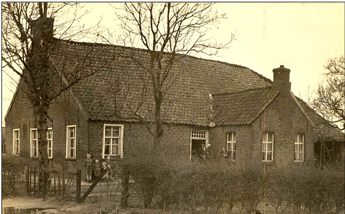
Lüdeweg Nummer 24 bis zum Abbruch 1939
